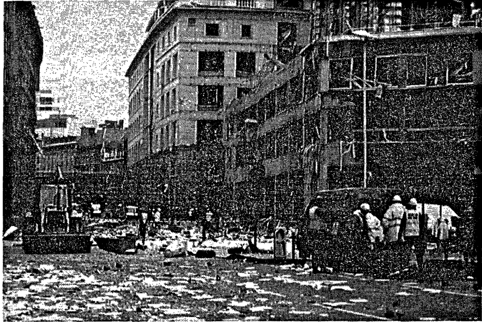
Werkers en polisieëre besig om op te ruim na die bom van die Ierse Republikeinse Leër in die finansiële distrik van Londen ontplof het. Een mens is dood en 30 beseer in die ontploffing en die skade word op 1,5 miljard Amerikaanse dollar bereken (Foto: AP)
