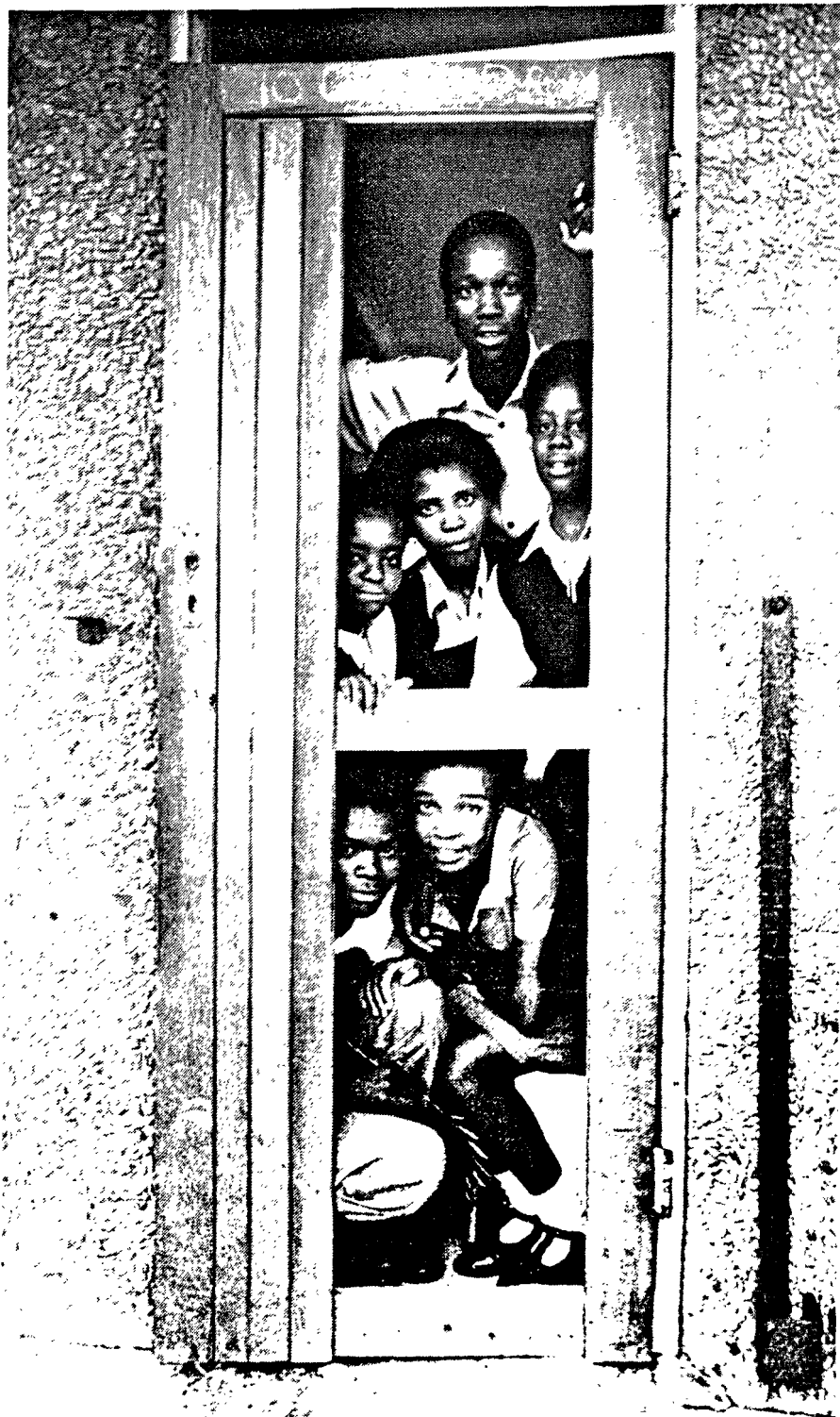
'n Groepie leerlinge loer deur een van die talle stukkende deure in die hoërskool Alexandra.
