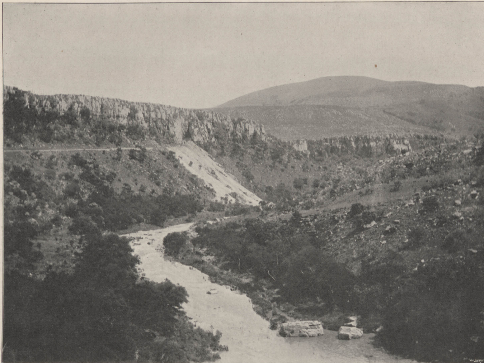
Tunnelingang Oost (uit de verte gezien).
