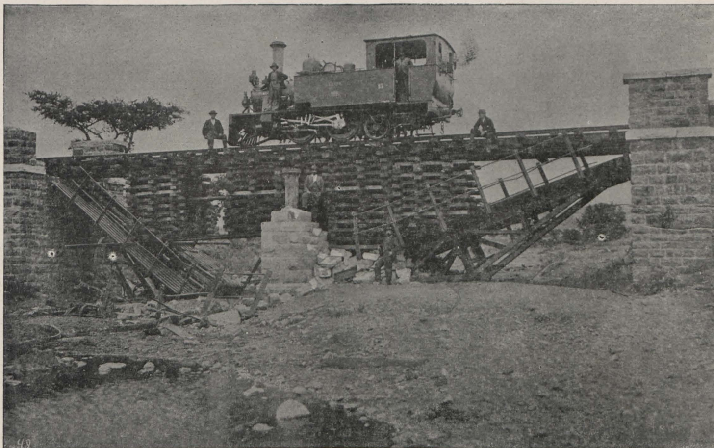
PONT RESTAUR SUR LE ZONDAG.
